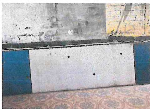
Foto 3: Reparación Muro Perimetral de Block
