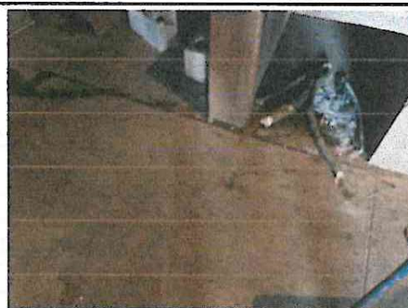
Foto 2: Reparación de Piso de Granito en Cocina
