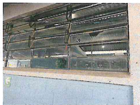
Foto 4: Sustitución de Vidrios en Salones de Clases.
